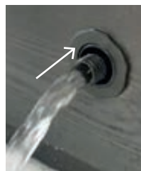
4. Zatlačením ventilu dovnitř se průtok vody zvýší
