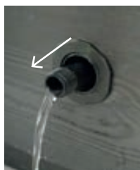
5. Vytažením ventilu se průtok vody sníží
